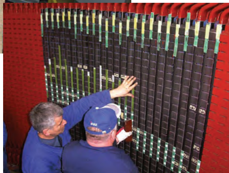
Рис. 1. Подготовка статора гидрогенератора (перед установкой датчика магнитного потока)
