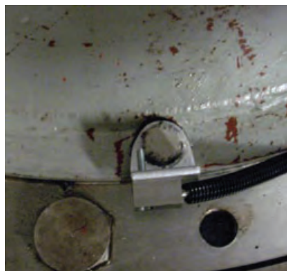
Рис. 6. Примеры установки акселерометров на подшипнике турбины, демонстрирующие простоту установки и обслуживания (используются акселерометры Brüel & Kjær Vibro AS 0070/02). Акселерометры установлены на корпусе подшипника турбины — один в направлении X (справа), а второй в направлении Y (слева). Подшипник генератора (не показан) оборудован одним радиальным (направление X) и одним осевым (направление Z) акселерометрами, разнесенными на 90 градусов.
